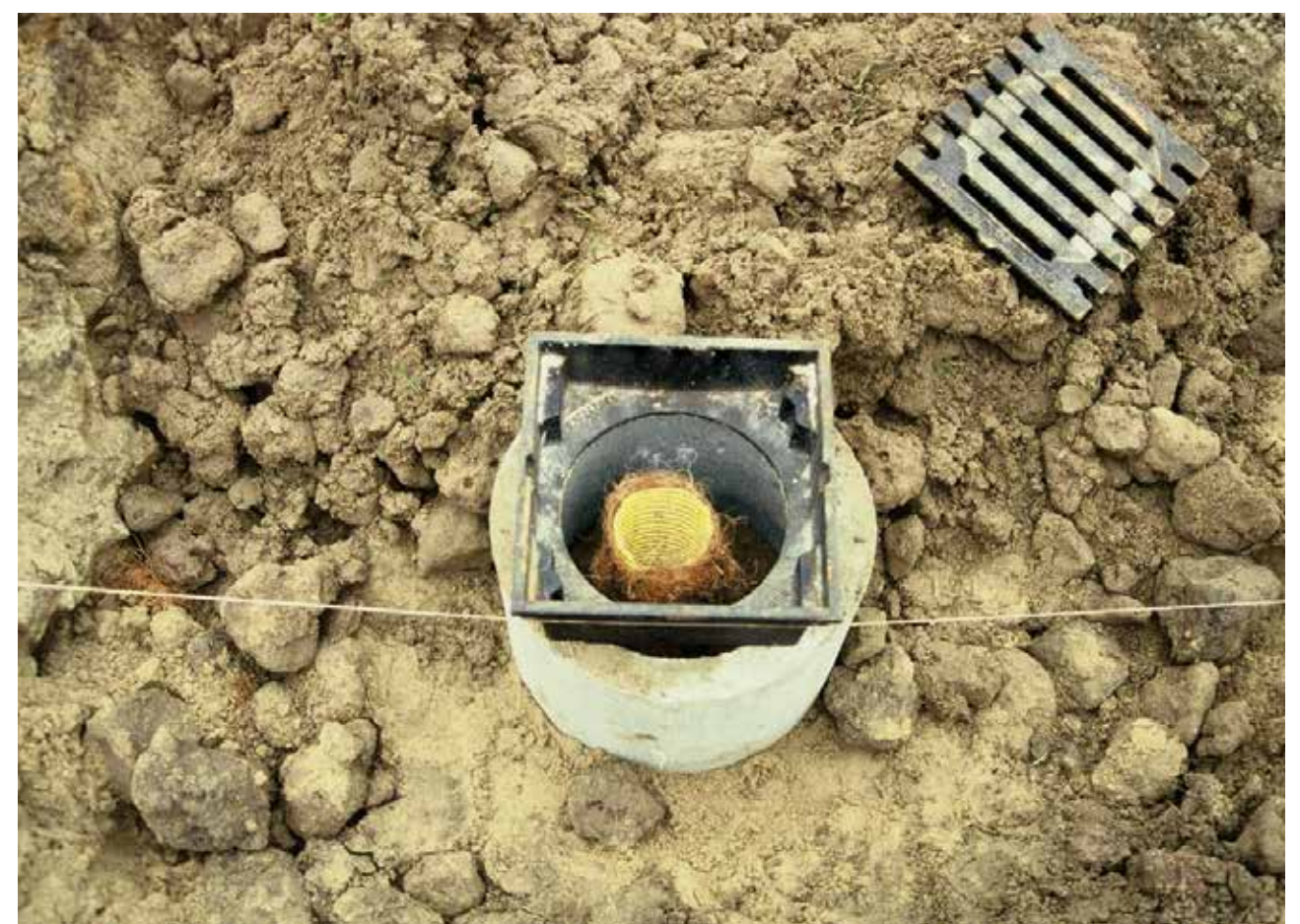
9 pav. Šaknys aprūpinamos oru ir vandeniu, įleidžiamas perforuotas vamzdis
