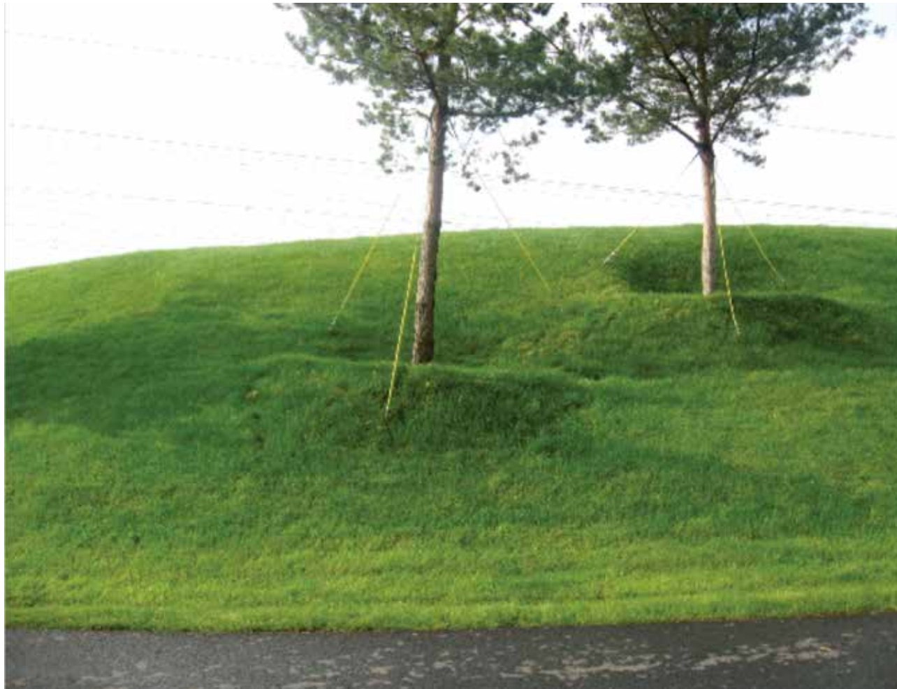
Didelių medžių tvirtinimas šlaite
