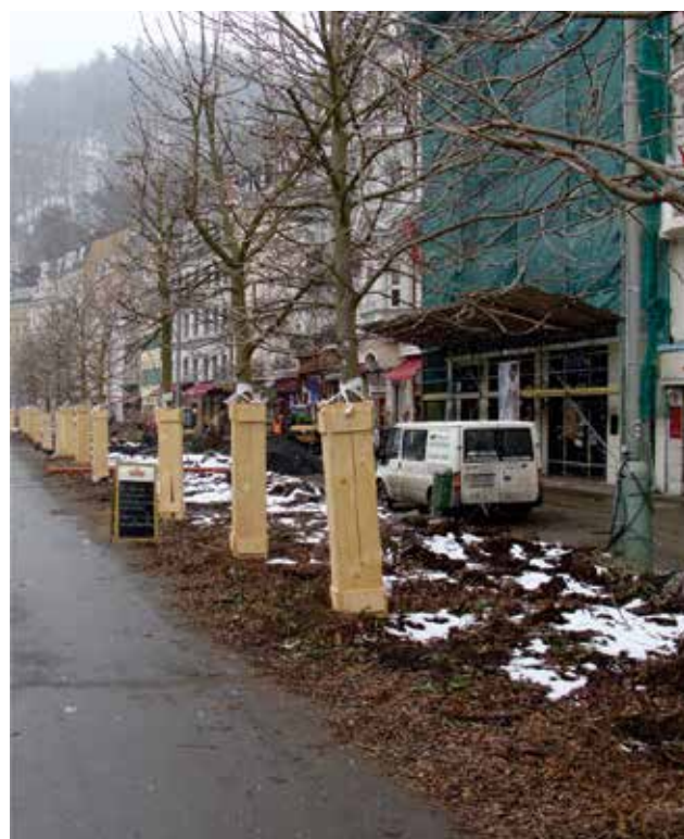
Medžiu kamienu apsauga vykdant gatvės rekonstrukcijos darbus
