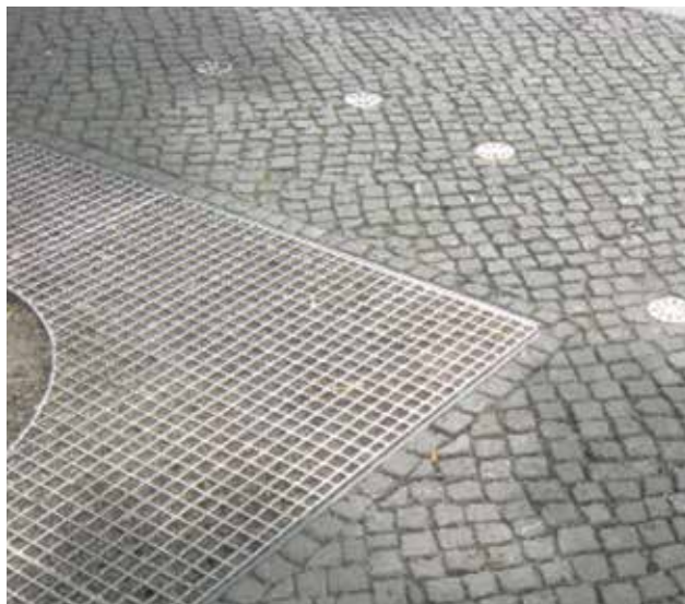
Atlikus minėtus darbus, galima ramiai kloti grindinį, nes šaknys tikrai negaus didelio spaudimo ir bus aprūpintos deguonimi ir vandeniu
