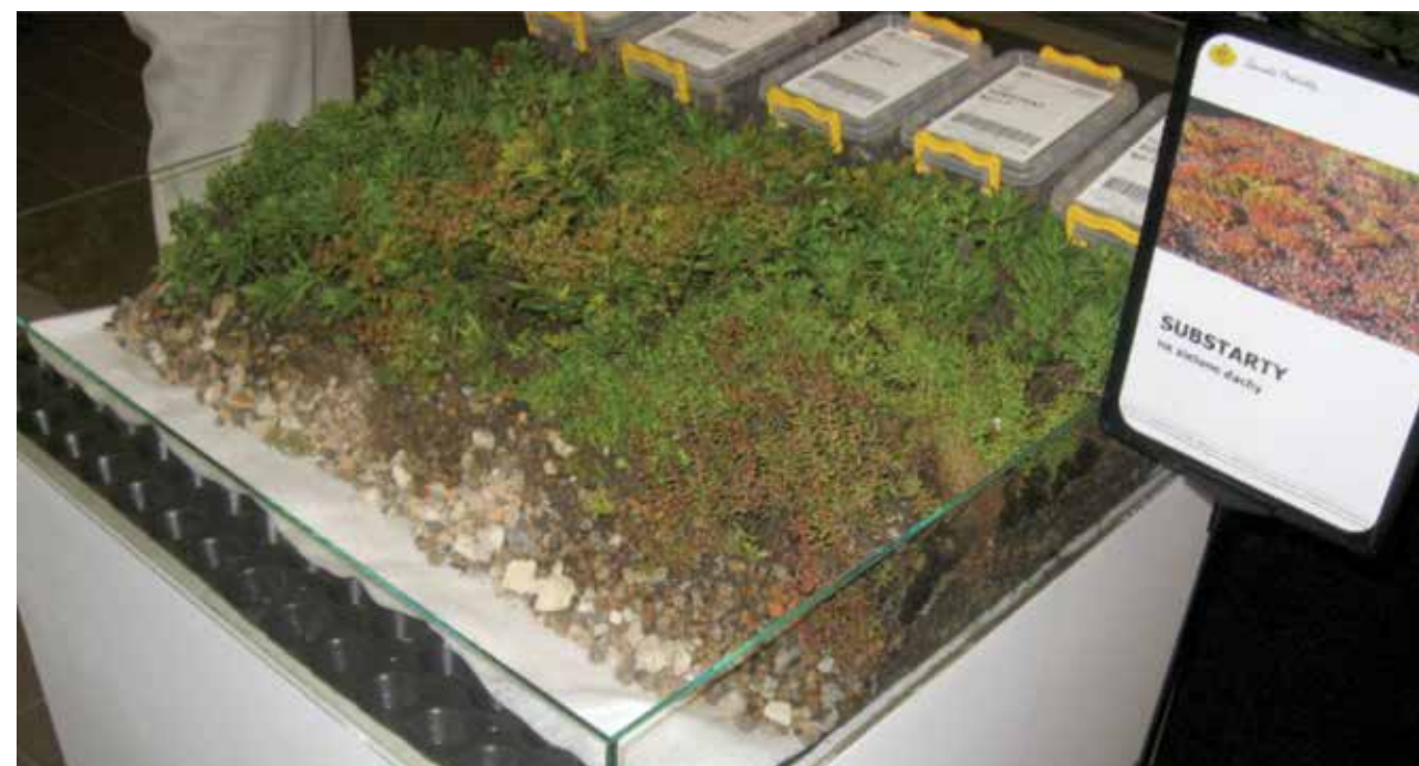
Stogo apželdinimo pavyzdinė konstrukcija
