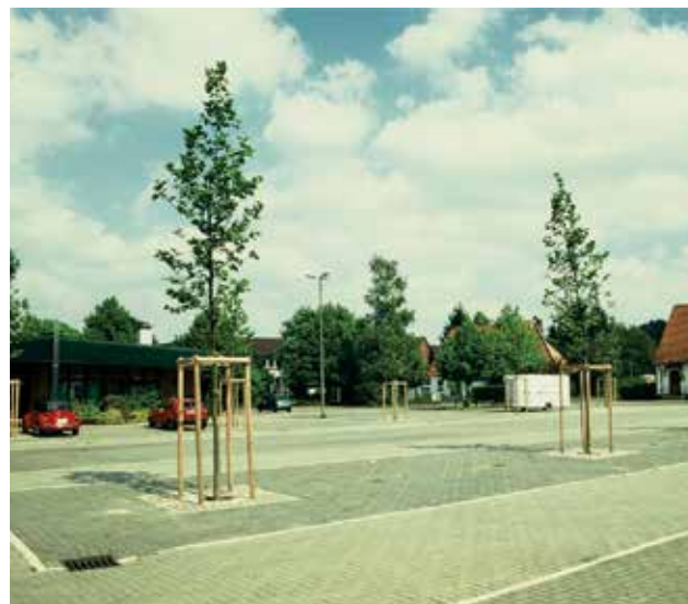
Atlikus minėtus darbus, galima ramiai kloti grindinį, nes šaknys tikrai negaus didelio spaudimo ir bus aprūpintos deguonimi ir vandeniu
