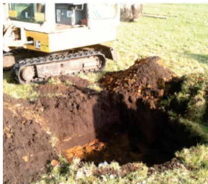
Sodinant medžius labai svarbu paruošti tinkamo dydžio duobę, atsižvelgiant į šaknų sistemą
