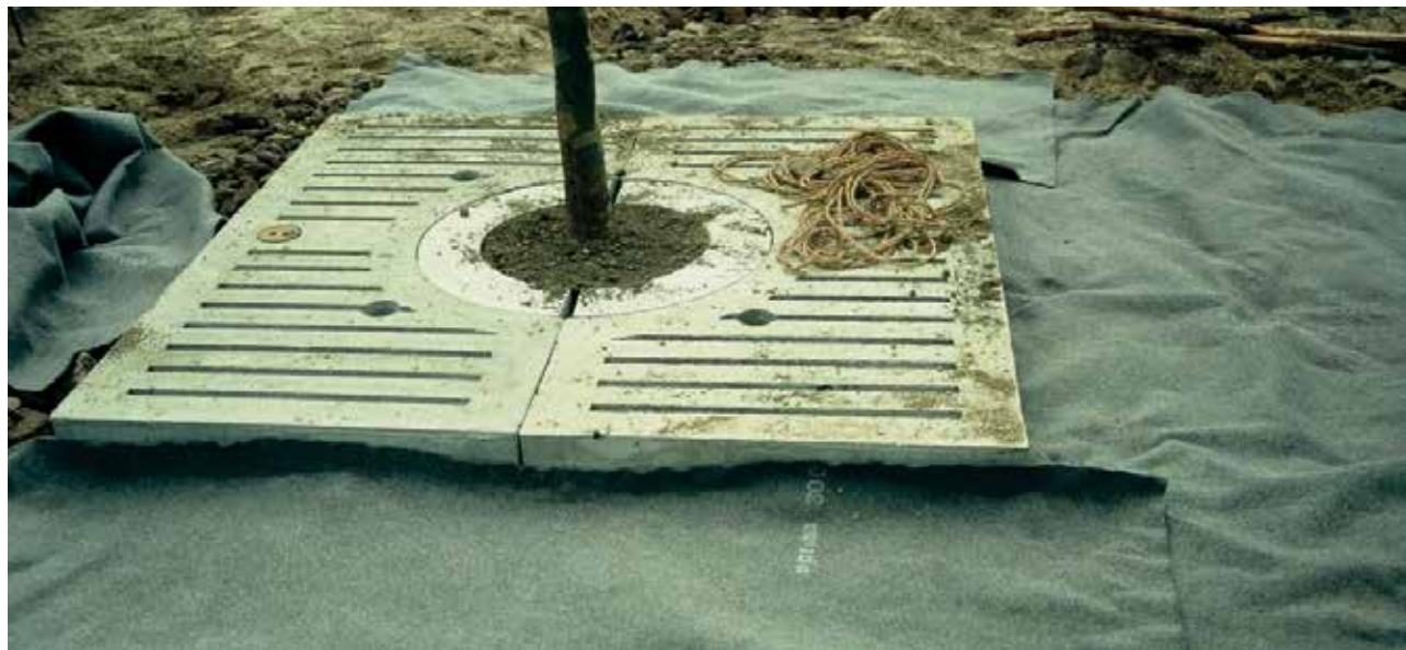
Kad augalų šaknys neiškilnotų grindinio, naudojama geotekstilė
