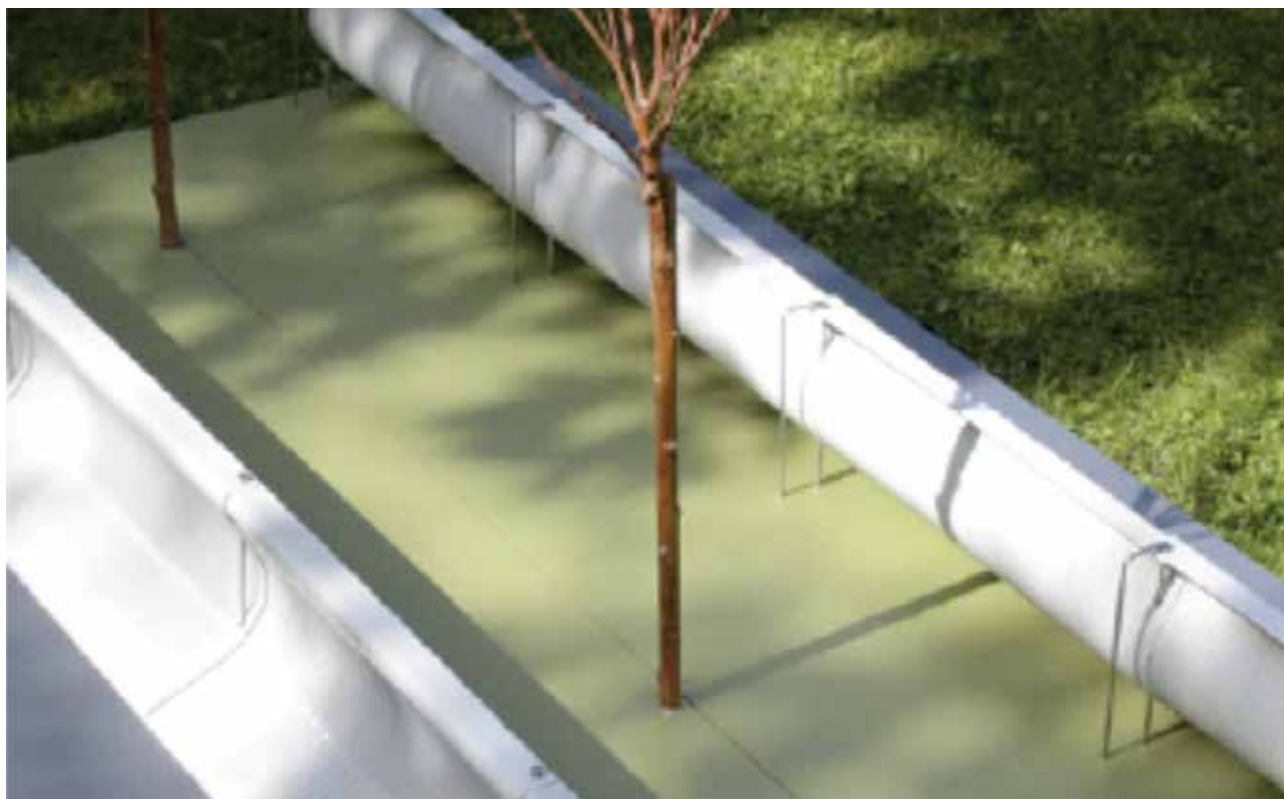
Apsauginė medžių tvorelė saugo nuo mechaninių pažeidimų ir kelio druskų
