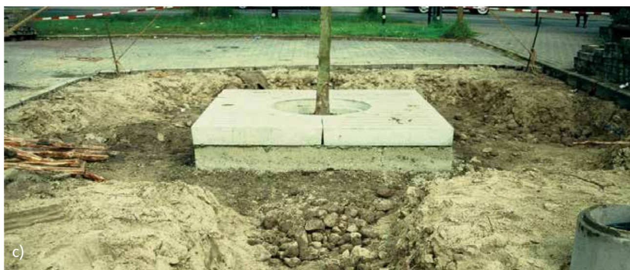
8 pav. Aplink šaknis padaromas atraminis bortas, kuris neleis užspausti augalo šaknis
